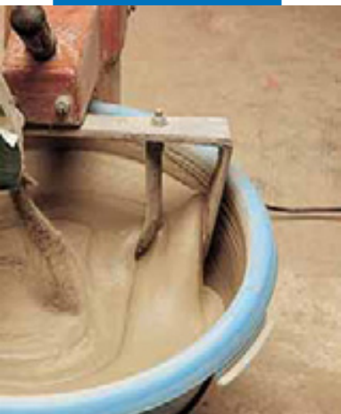
Смешивание серого Planiseal 88 с водой
