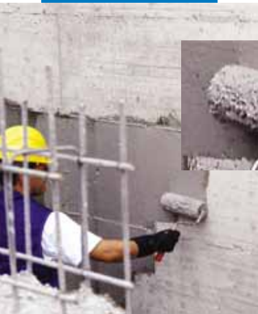
Пример гидроизоляции фундамента с помощью валика
