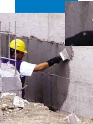
Пример гидроизоляции фундамента с помощью кисти
