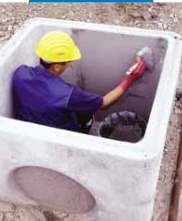
Пример гидроизоляции шахты люка с помощью кисти
