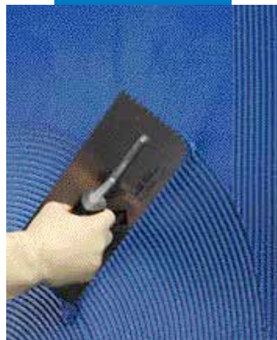
Нанесение Keraflex Design синего цвета с помощью зубчатого шпателя
