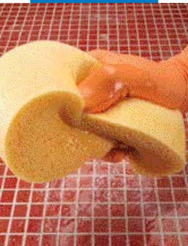
Увлажнение поверхности швов перед очисткой
