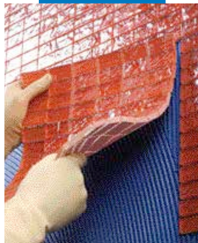
Укладка стекломозаики с помощью Keraflex Design на стену
