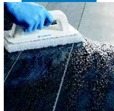
Очистка швов с помощью Scotch-Brite
