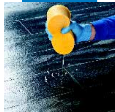
Увлажнение поверхности швов перед очисткой
