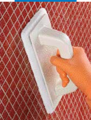
Очистка стекломозаики с помощью влажной губки Scotch Brite®
