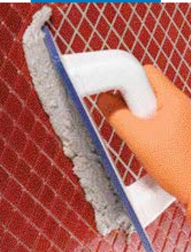
Нанесение Kerapoxy Design
